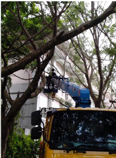
說明：施工中之影響太陽能板之電腦教室旁榕樹群
