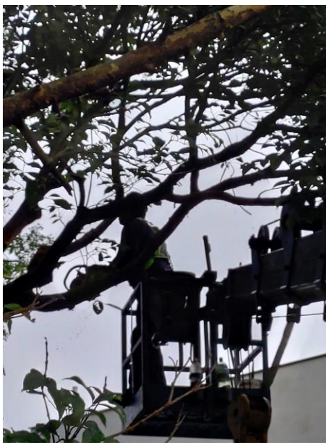
說明：施工中之東側民居旁榕樹
