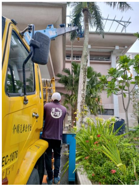
說明：施工前之影響太陽能板之川堂旁亞歷山大椰子
