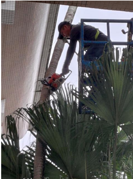
說明：施工中之影響太陽能板之川堂旁亞歷山大椰子
