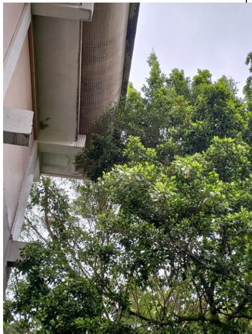
說明：施工前之影響太陽能板之電腦教室旁榕樹群
